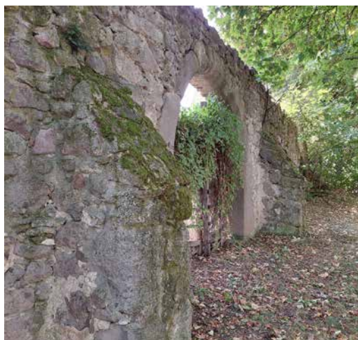
Múr zaniknutého kostola v Kemence
