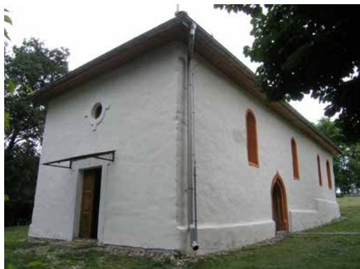
Juhozápadný pohľad na kostol po obnove s pravouhlým portálom a kruhovým okienkom (2008)
