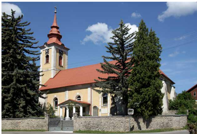
Celkový pohľad na kostol z juhovýchodu
